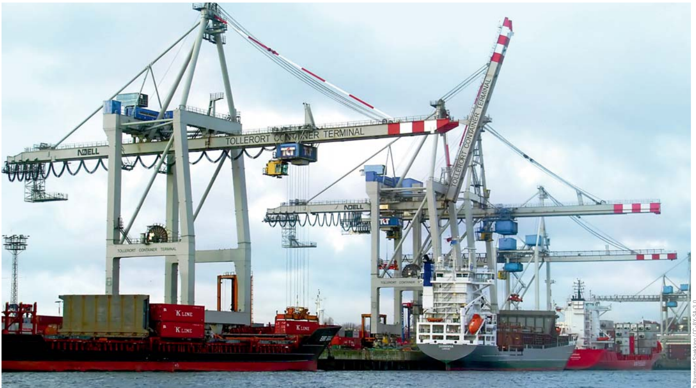
Containerterminal Tollerort im Hamburger Hafen
