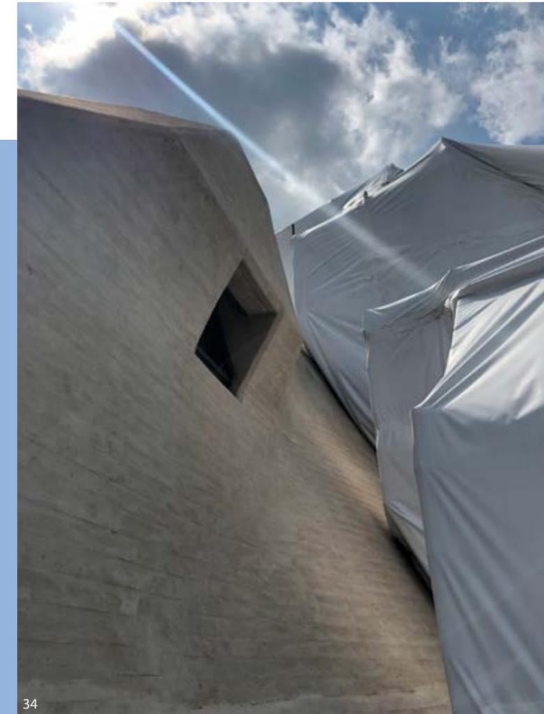
Der Bau war viele Jahre lang stark sanierungsbedürftig, da Undichtigkeiten zu anhaltender Feuchtebelastung des Stahlbetons, Korrosion seiner Armierung und damit zu Schäden der gesamten Konstruktion führten.
