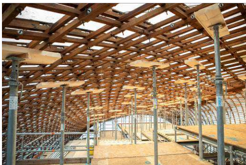
01_Multihalle Mannheim von Frei Otto: Schwerlastsprieße drücken die Holzkonstruktion an einer Probefläche in ihre ursprüngliche Geometrie. Foto: Arthur Bauer / Wüstenrot Stiftung
