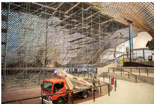
03_Multihalle Mannheim von Frei Otto: Innenraum mit aufgebautem Raumgerüst. Foto: Arthur Bauer / Wüstenrot Stiftung
