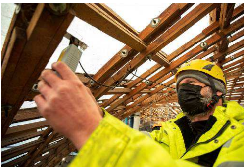
04_Multihalle Mannheim von Frei Otto: Messungen an der Holzkonstruktion. Foto: Arthur Bauer / Wüstenrot Stiftung
