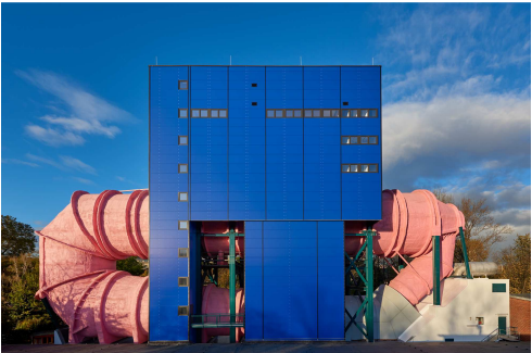
01_Umlauftank 2 Berlin von Ludwig Leo: Blick von Süden nach der Instandsetzung 2017. Foto: Philipp Lohöfener / Wüstenrot Stiftung
