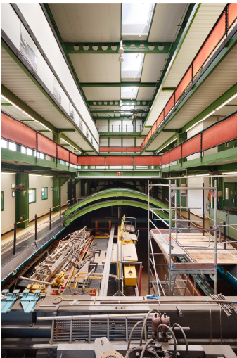
03_Umlauftank 2 Berlin von Ludwig Leo: Blick gegen die Strömungsrichtung auf der Messstrecke während der Instandsetzung. Foto: Philipp Lohöfener / Wüstenrot Stiftung
