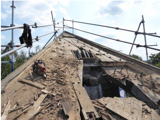
Sonnensegel Dortmund von Günter Behnisch: Freigelegte Holzmembran mit entfernten schadhaften Bereichen. Foto: Thomas Knappeide / Wüstenrot Stiftung
