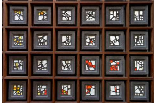
03_Kapelle der Kaiser-Wilhelm-Gedächtniskirche von Egon Eiermann: Holzraster auf der Innenseite der Betonglaswand. Foto: Thomas Wolf / Wüstenrot Stiftung
