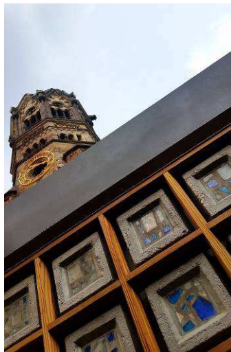
05_Kapelle der Kaiser-Wilhelm-Gedächtniskirche von Egon Eiermann: Ansicht Holzraster mit Betonglaswand vor historischer Turmruine. Foto: Alexander Flöth / ARTEFAKT Kulturkonzepte
