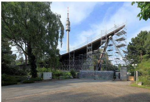
01_Sonnensegel Dortmund von Günter Behnisch: Ansicht Sonnensegel mit Baugerüst. Foto: Hans Jürgen Landes / Wüstenrot Stiftung
