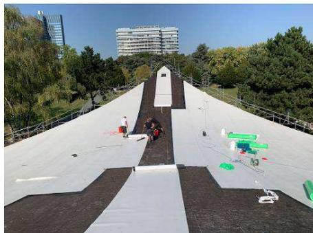
14\_Eindecken mit Bitumen und Folie, 2020. Foto: HWR Architekten
