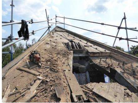
10\_Freigelegte Holzmembran mit entfernten schadhafte Bereichen. Foto: Thomas Knappheide.
