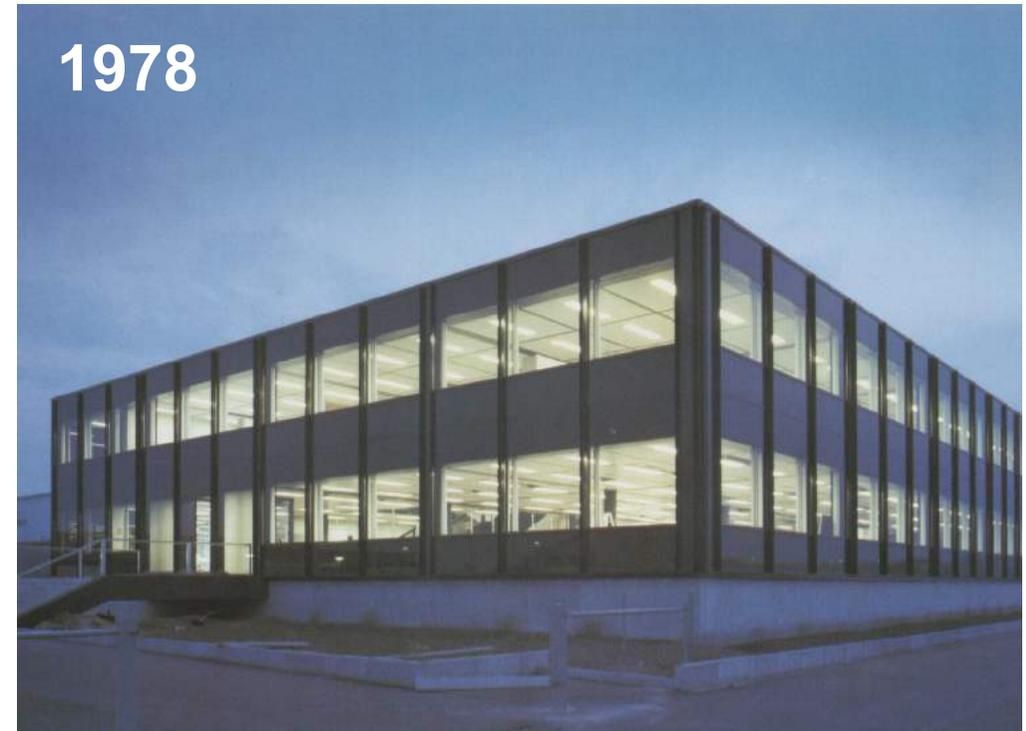
Gesamtfassade in Aluminiumkonstruktion (DBP ang.), technisch eloxiert, mit eingebauten Dreh- und Kippflügeln; Konstruktion und Ausführung GARTNER
