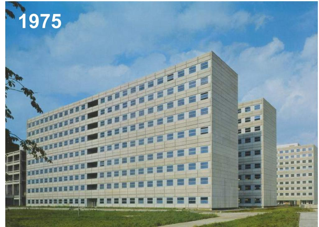
*(...) Bettenhäuser mit H-förmigem Grundriß (...) Fensterbänder (...) mit 2,40/1,80 m großen Vertikal-Schiebefenstern und dazwischenliegenden Aluminium-Paneelen (...)*
