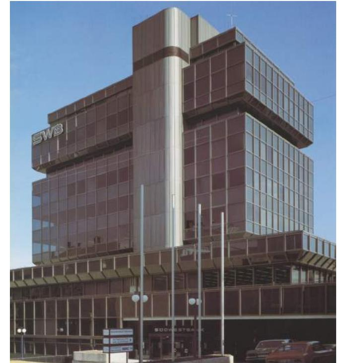
*Metallbauarbeiten an dem stufenförmig abgesetzten 9 geschossigen Verwaltungsgebäude. Die Fassade in Pfosten-Riegel-Bauweise, Achsmaß 1,875 bzw. 1,625 mm. (...)*
