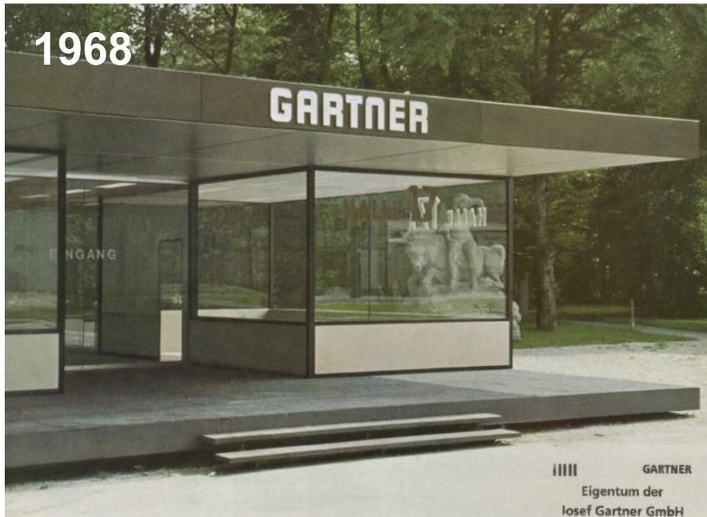
*(...) Die (Stahl-)Außenstützen sind als rechteckige Rohrstützen ausgeführt (...) und in den Kreislauf der Warmwasserheizung einbezogen. (...) klimatisiert (...)*
