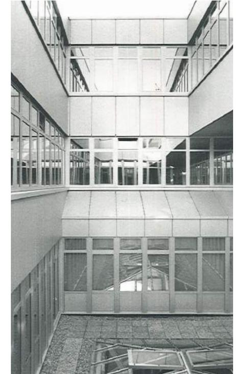
*Vorgehängte Glasfassade (...)* Die Fassadenunterkonstruktion aus IPE-Profilen ist an der Attika aufgehängt und stützt sich gegen die Geschoßdecken. Die Fassadenplatten aus metalloxidbeschichtetem Einscheiben-Sicherheitsglas, Typ S020 durchsichtig vor Fenstern und Typ E020 emailliert vor Brüstungen (...)
