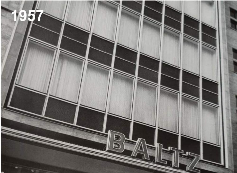
*Fassadenglaswand in Aluminiumkonstruktion Patent GARTNER (DBP und Ausl. Patente), (...) Emallierte Brüstungsplatten*
