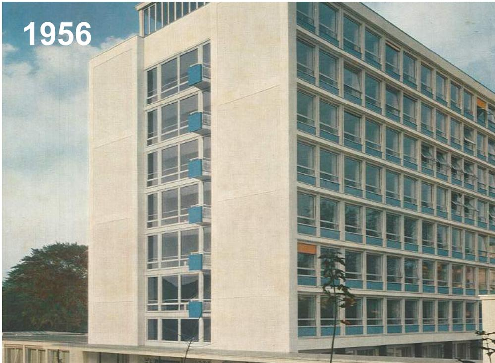
*(...) Gesamtbau Aluminium-Schwingflügelfenster (180° drehbar) einzeln und in Fenstergruppen; Bauart Gartner; DBP und Ausl. Pat. ang. (...) alles technisch eloxiert*
