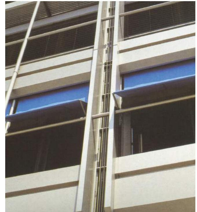
*Aluminium-Vorsatzfassade (...), in freitragend hängender Konstruktion aus doppelten Profillisenen und dazwischenliegenden Zuggliedern. (...)*
