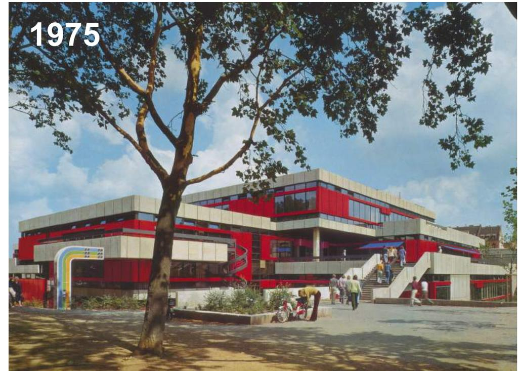
*Geschoßhohe Glaswände in Stahl-Aluminium-Konstruktion, frei gespannt bis 9,00 m Höhe. (...) Kastenförmige Wand- und Brüstungselemente mit Aluminium-Paneelen (...)*
