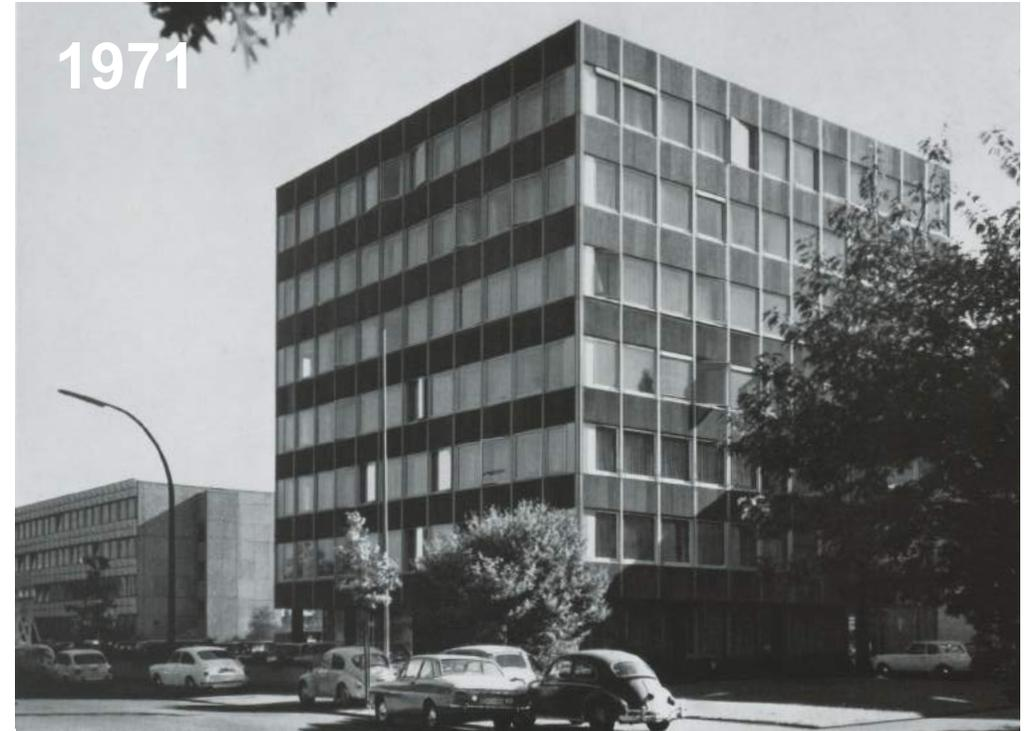
*Fassadenglaswände aus Aluminium, im Naturton eloxiert, mit eingebauten Wendeflügeln 360° drehbar (...) die Brüstungsfelder mit Naturstein-Verkleidung*
