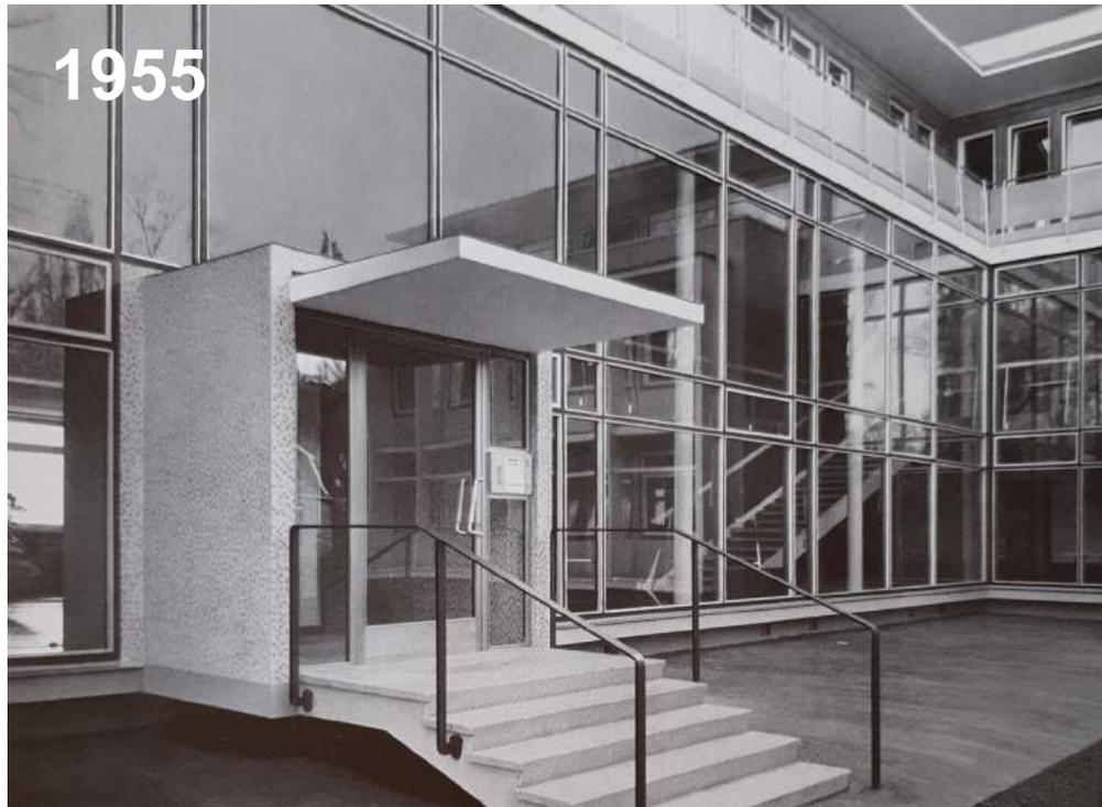
*Eingang und Fensterwand in Aluminiumkonstruktion; Bauart GARTNER*
