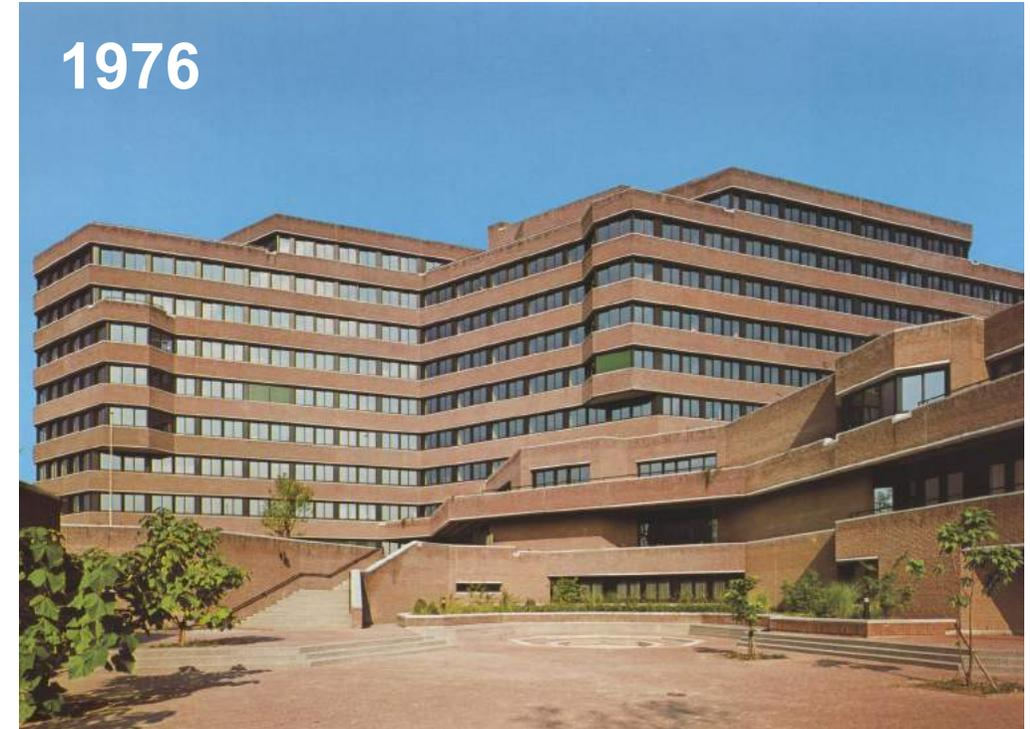
*Fensterbänder der Normalgeschosse im Hochhaus Aluminiumkonstruktion Bauart Gartner, mit oberen und unteren Kippflügeln (...) geschliffen und eloxiert*
