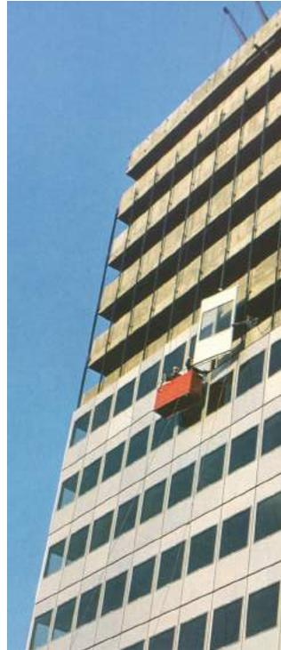
*Fassade aus 600 gleichen, geschoßhohen und ebenen Wandelementen (...) in Sandwich-Konstruktion, mit Neoprene-verglasten Wendeflügeln. (...)*
