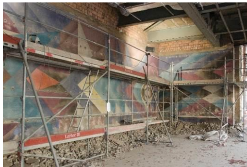
06_Rechte Seite nach Entfernung der Sandsteinplatten und des Vergussmörtels (November 2020) © Dipl. Rest. (FH) Martin Fliedner
