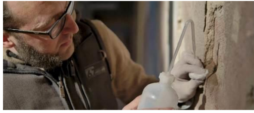
02_Stabilisierung entfestigter Bereiche durch Restaurator M. Fliedner © Wüstenrot Stiftung
