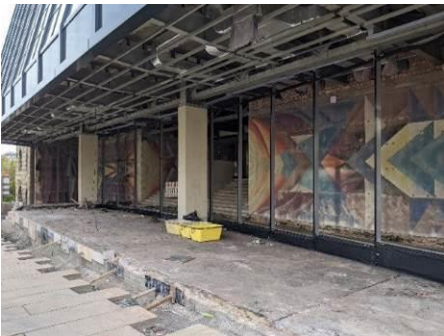
13_Außenansicht der Baustelle am Rathaus mit freigelegter Wandgestaltung (Oktober 2021) © Wüstenrot Stiftung
